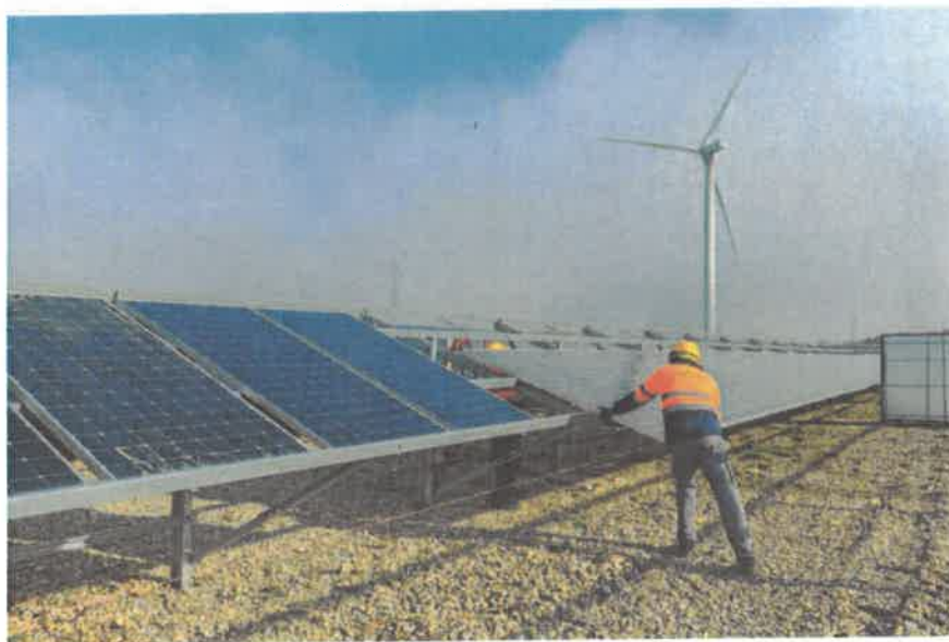
Chantier du parc photovoltaïque de Beaucaire, 2 (Implantation similaire prévue sur Domitia)
